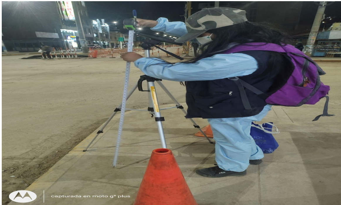
Figura 29: Instalación del trípode a una altura de 1.5 m sobre el piso, Puno 9 (Intersección Av. Floral con Av. la Torre).
